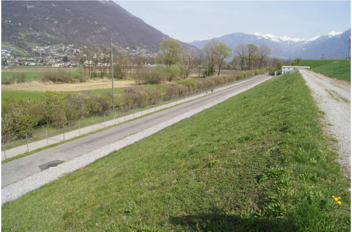
Figura 13: Vista della zona umida adiacente il Pizzante, a nord della strada di accesso.
