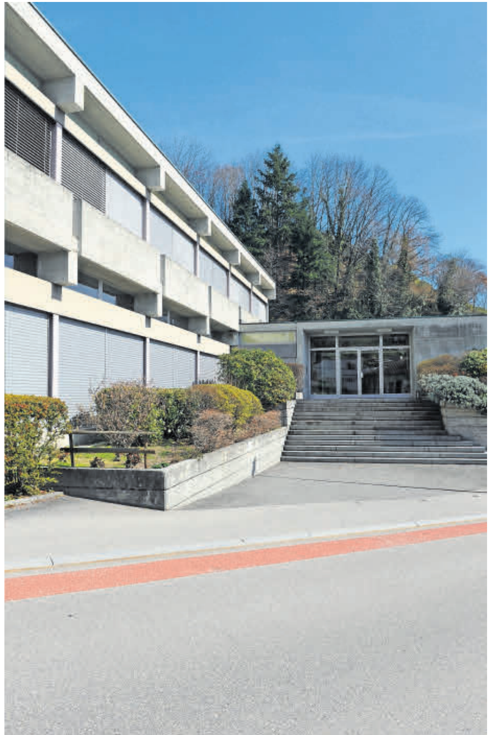
DA SISTEMARE Le scuole al Burio hanno più di 45 anni e necessitano di pesanti lavori di ristrutturazione. Alcuni, urgenti, hanno già dovuto essere eseguiti. (Foto Archivio CdT)
