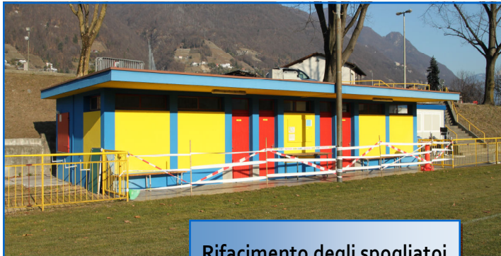
Rifacimento degli spogliatoi al campo di calcio
